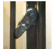
4. Flügelheber mit integrierter Fehlschaltsicherung
